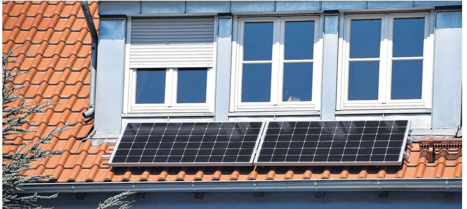
Stecker-Solaranlagen bestehen aus ein oder zwei Modulen und einem Wechselrichter. Der wandelt die aus der Sonneneinstrahlung erzeugte Energie direkt in Strom um.
